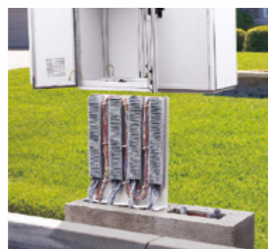
ARMÁRIO ATIVO SENDO COLOCADO
