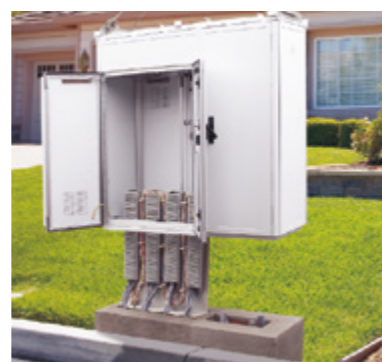
ARMÁRIO ATIVO SENDO COLOCADO
